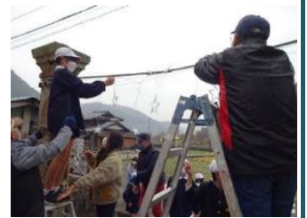
イルミネーション取付の様子
